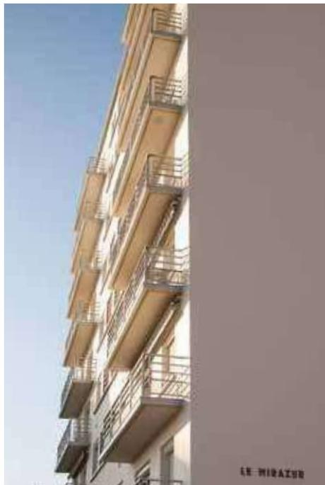
Pour ce projet situé en périphérie de Blois, des pièces spécifiques ont été créées pour fixer certains garde-corps sur la façade. Le modèle LAZULI à travers son profil rectiligne s'intègre parfaitement à l'environnement typique des constructions des années 70. Le RAL 7035 et la tôle poinçonnée lui donnent une touche de modernisme.
