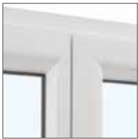
Masse centrale équipée d'une pareclose contemporaine.
