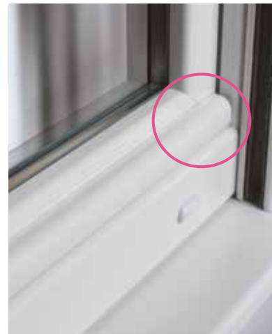
Jet d'eau EN OPTION Améliore l'étanchéité.
